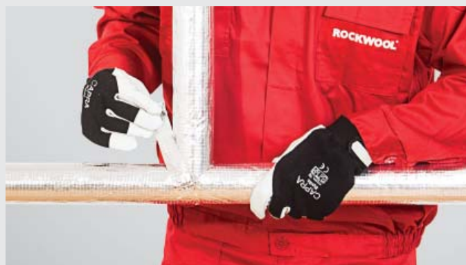
FOT. 414.19. Sklejenie styków izolacji taśmą aluminiową.
