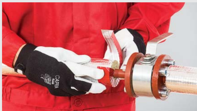
FOT. 414.24. Zabezpieczenie zakończenia odcinka prostego izolacji przy zaworze mankietem aluminiowym.
