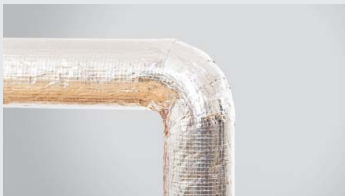
FOT. 414.14. Gotowe kolano zaizolowane otuliną ROCKWOOL 800 z jednym segmentem kolanowym.
