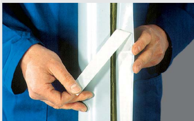
FOT. 414.2. Na odcinek prosty rury nakłada się otulinę TERMOROCK , a następnie odrywa taśmę zabezpieczającą i przykleja zakładkę samoprzylepną.
