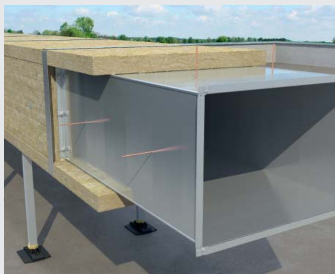
WIZ. 2. Układanie płyt ROCKTERM wraz z mocowaniem szpilkami zgrzewanymi do blachy kanału.
