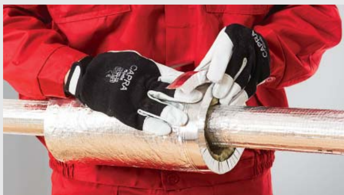
FOT. 414.22. Zabezpieczenie zakończenia izolacji mankietem aluminiowym.
