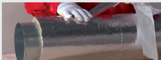
FOT. 411.3. Krok 3 – uszczelnienie taśmą aluminiową połączeń podłużnych i poprzecznych.
