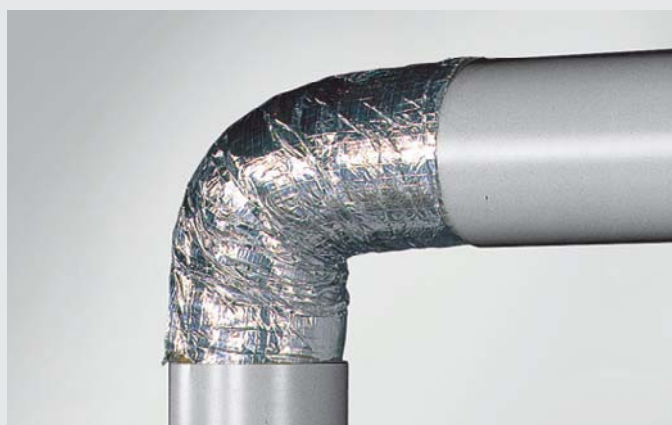
FOT. 414.4. Na odcinek prosty za kolaniem ponownie nakłada się otulinę TERMOROCK .
