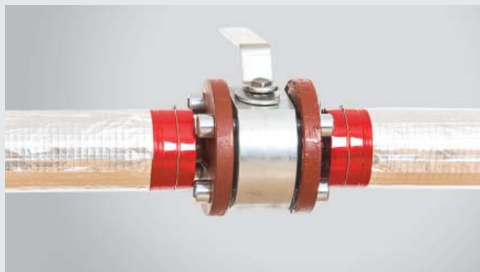
FOT. 414.25. Gotowa izolacja rurociągu przy zaworze, gdy nie ma możliwości izolacji zaworu.
