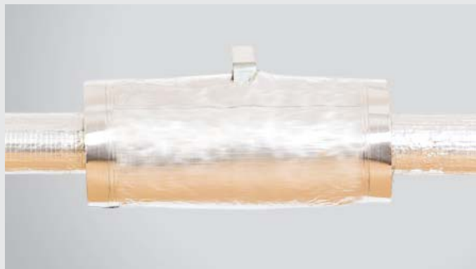
FOT. 414.23. Gotowa izolacja zaworu przy użyciu ALU LAMELLA MAT.
