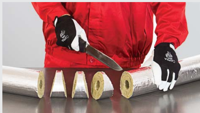
FOT. 414.10. Wycinanie segmentów kolanowych.
