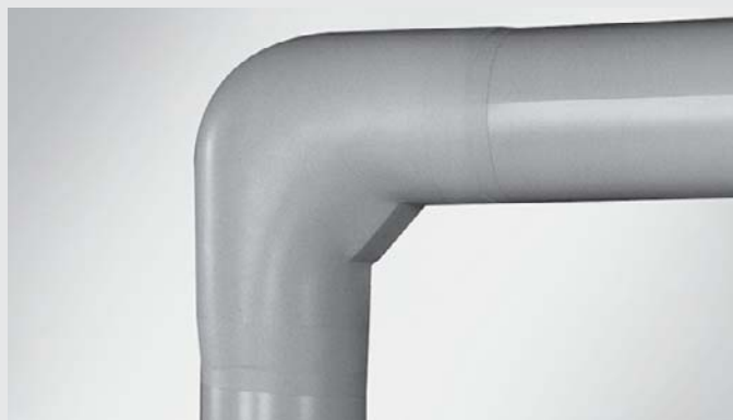
FOT. 414.5. Na zaizolowane kolano nakłada się osłonę PCV, sklejając wszystkie połączenia taśmą PCV.
