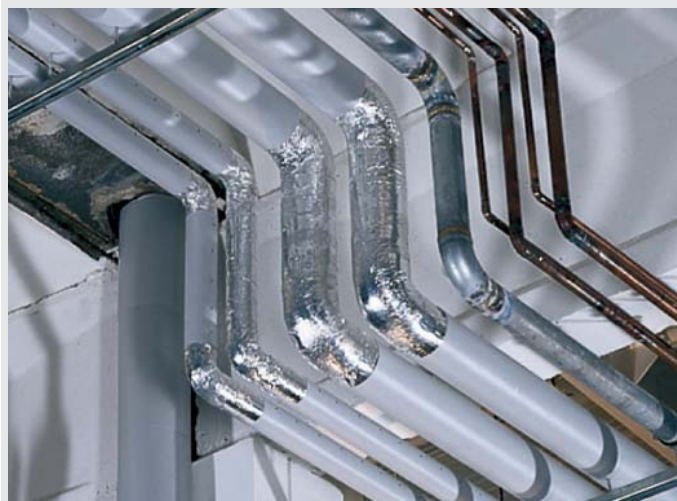
FOT. 414.1. Izolacja wykonana systemem TERMOROCK .
