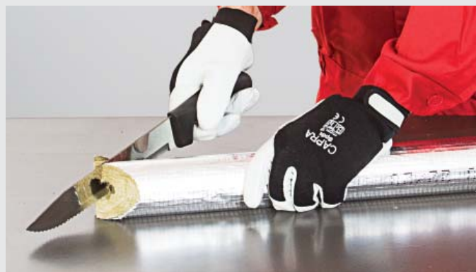
FOT. 414.16. Wycięcie klina 2 x 45° w odcinku izolującym odgałęzienie rurociągu.
