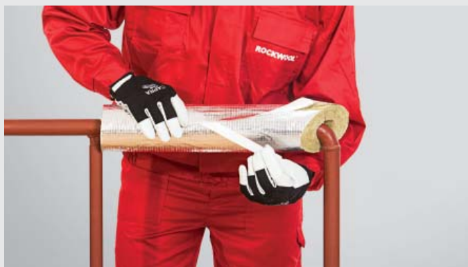
FOT. 414.6. Sklejenie połączenia wzdłużnego zakładką samoprzylepną.
