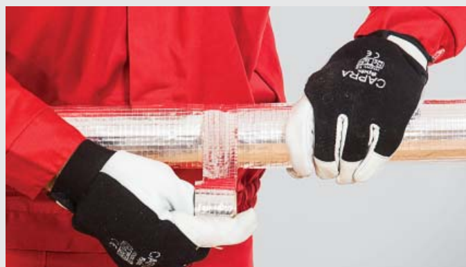
FOT. 414.4. Zabezpieczenie połączenia poprzecznego otulin samoprzylepną taśmą aluminiową.
