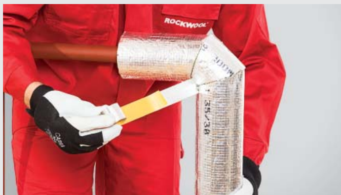
FOT. 414.13. Sklejenie połączeń poprzecznych taśmą aluminiową.
