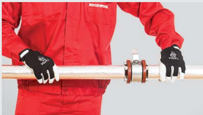
FOT. 414.20. Wstępne zaizolowanie odcinków prostych instalacji do zaworu odcinającego.
