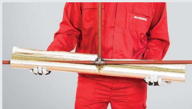
FOT. 414.17. Nałożenie dociętych elementów na odcinek poziomy i pionowy rury.
