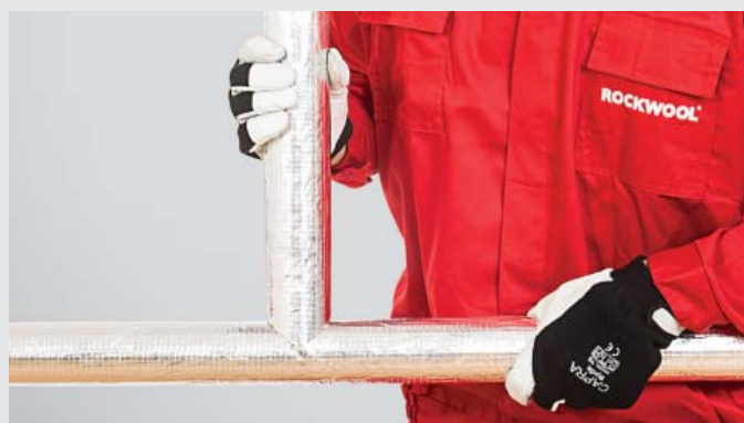
FOT. 414.18. Dopasowanie łączonych odcinków.
