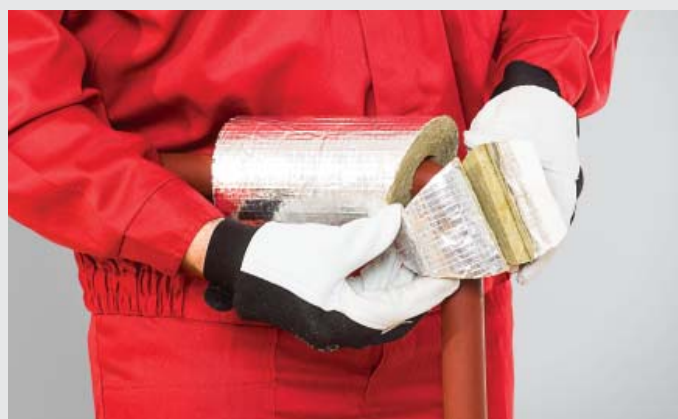
FOT. 414.11. Montaż jednego segmentu kolanowego.
