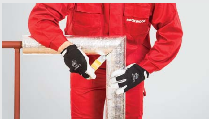
FOT. 414.8. Zabezpieczenie połączenia poprzecznego otuliny samoprzylepną taśmą aluminiową.
