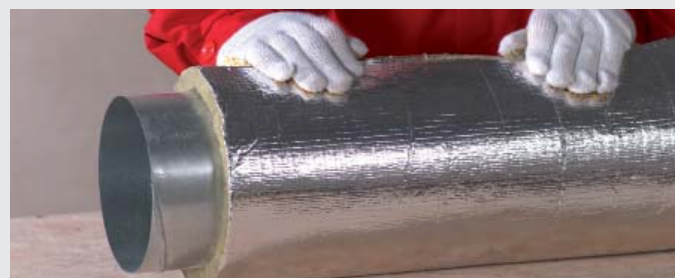
FOT. 411.2. Krok 2 – owinięcie kanału izolacją.
