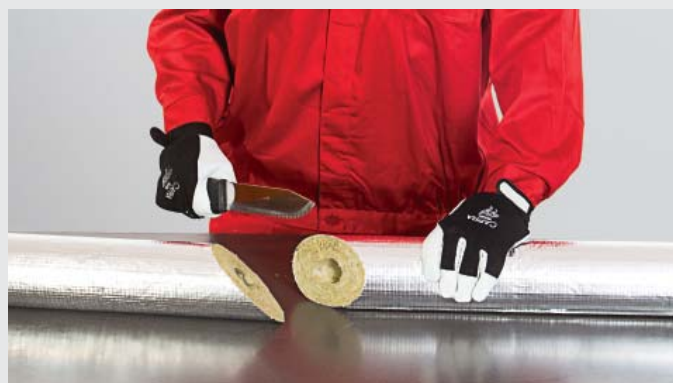
FOT. 414.5. Rozcięcie otuliny pod kątem 45° na dwa elementy.
