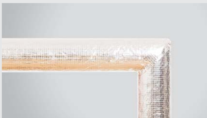
FOT. 414.9. Gotowa izolacja kolana z dwóch elementów otuliny ROCKWOOL 800.
