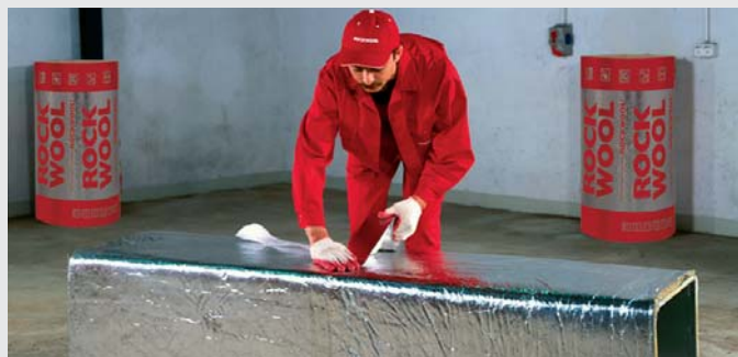
FOT. 411.8. Krok 4 – uszczelnienie taśmą aluminiową połączeń podłużnych i poprzecznych maty.
