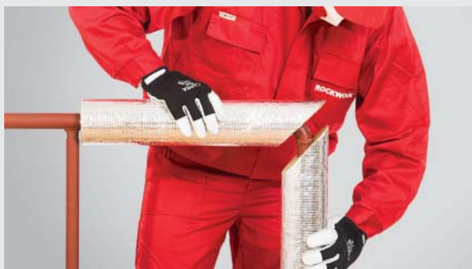
FOT. 414.7. Dopasowanie obu elementów izolacji kolana.
